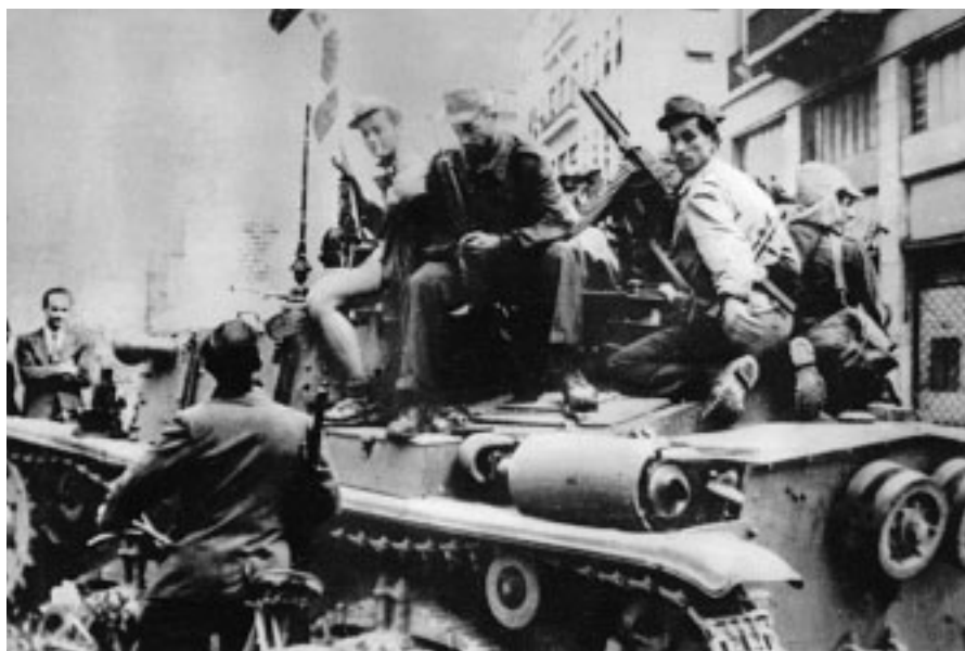
■ A Torino, nei giorni della liberazione: partigiani a bordo di un carro armato, montato dagli operai della SPA, si recano a snidare i fascisti asserragliati nell'albergo Nazionale.
