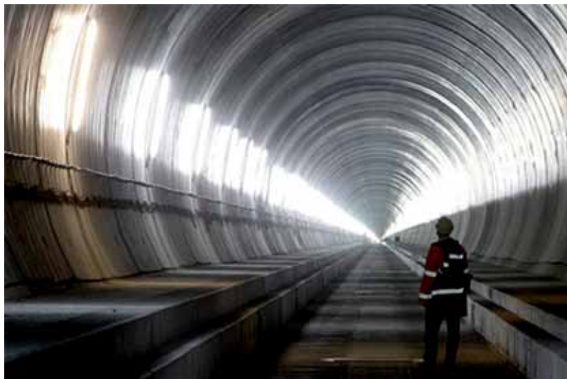
La galleria del tunnel del Gottardo
