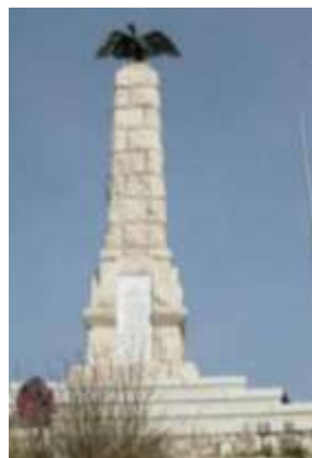
2012 dopo il restauro
