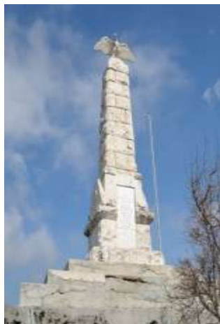
2011 prima del restauro
